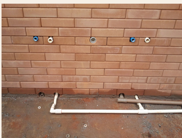
SAÍDAS DE CHUVEIRO, REGISTROS E DUCHA HIGIÊNICA EM PAREDE DE TIJOLO ECOLÓGICO APARENTE.
