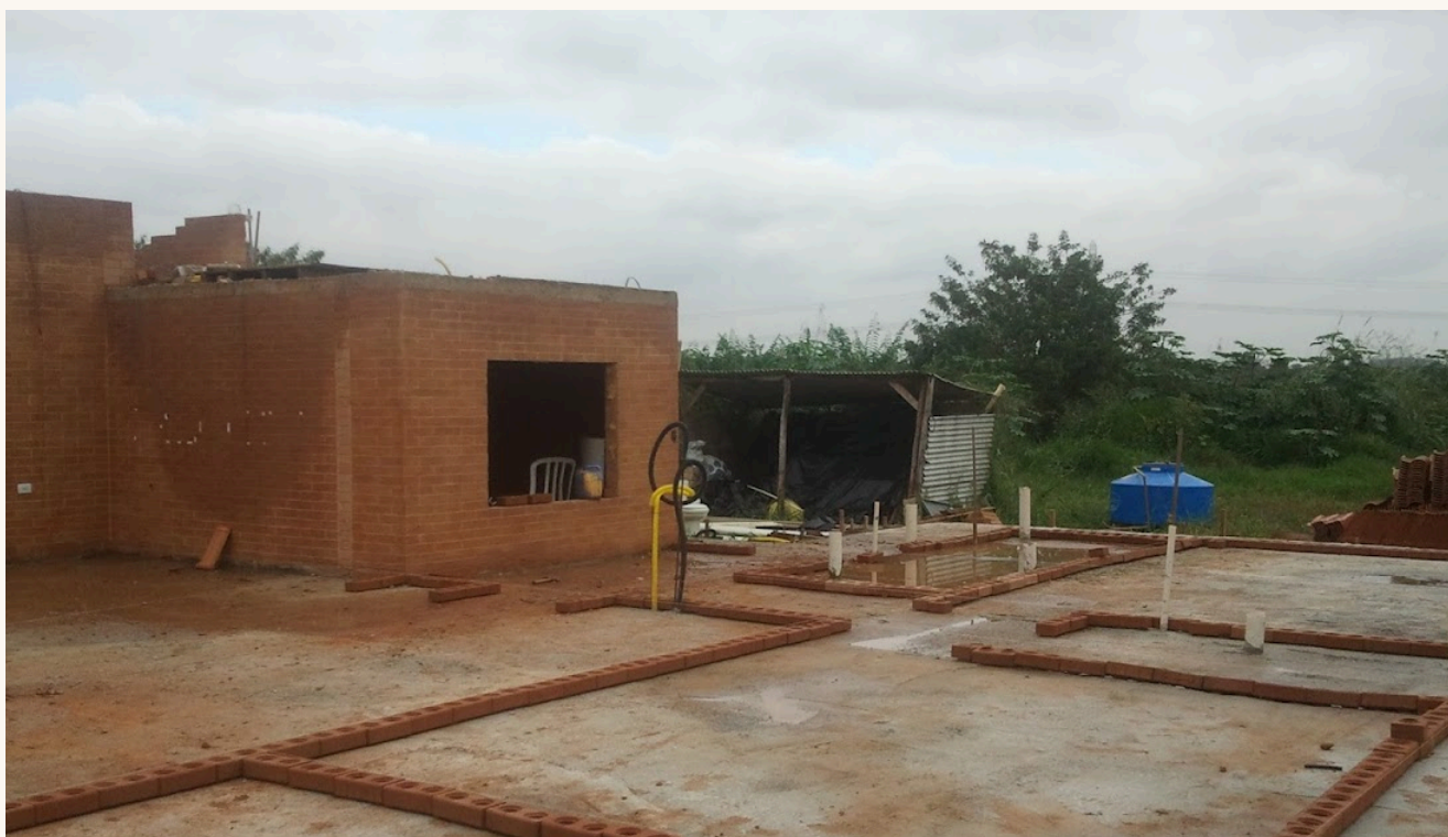
PRIMEIRA FIADA ASSENTADA SOBRE BALDRAME NIVELADO · OBRA EM FASE INICIAL.
