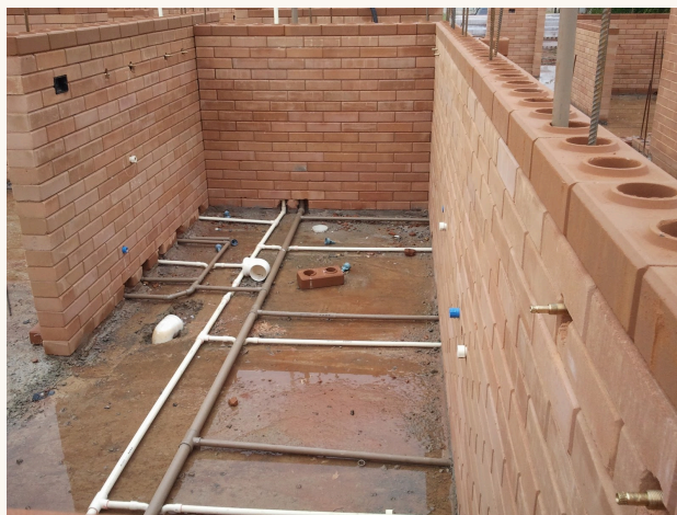
FUROS DO TIJOLO RECEBEM ELETRODUTOS VERTICAIS E OS RAMAIS HORIZONTAIS CORREM PELA CANALETA SUPERIOR.
